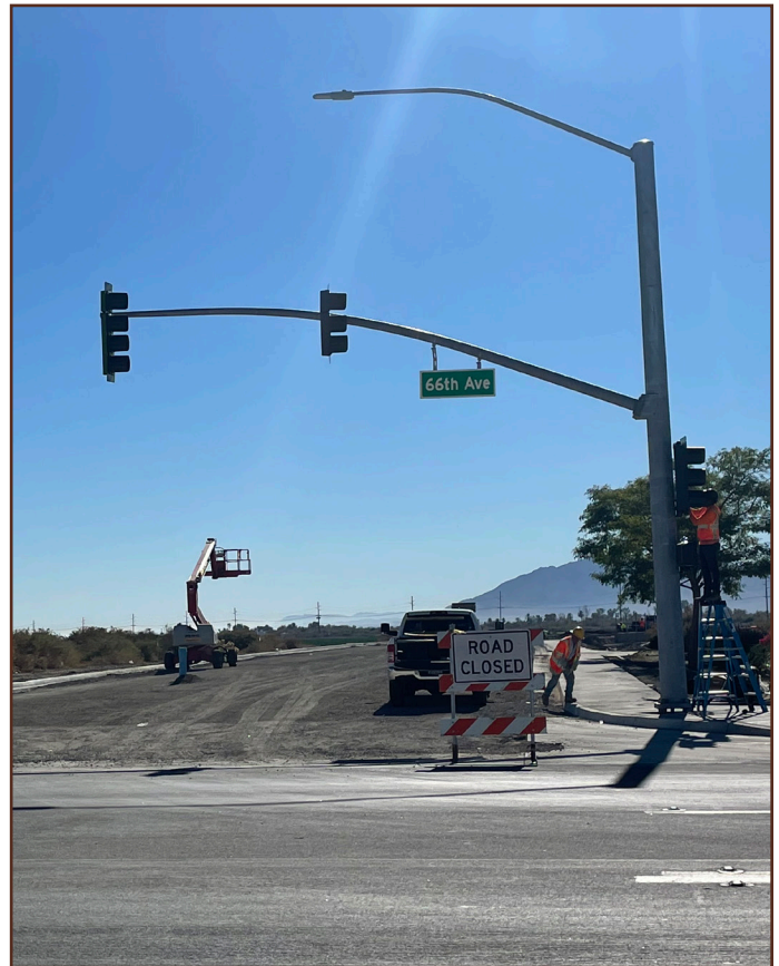
Las cuadrillas instalando el nuevo semáforo en la nueva intersección de Dale Kiler Road y Avenue 66 Bypass Road. La banqueta y la cuneta se completarán con la pavimentación próximamente. La nueva carretera se abrirá a principios del próximo año.
